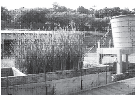
Figura 9.14 Vista do experimento da Unisinos com Banhados Construídos.
